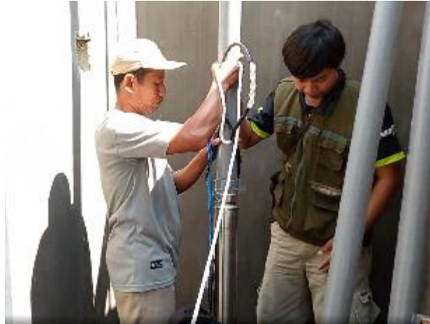
Gambar 1. Pemasangan Pompa Submersible Pump
