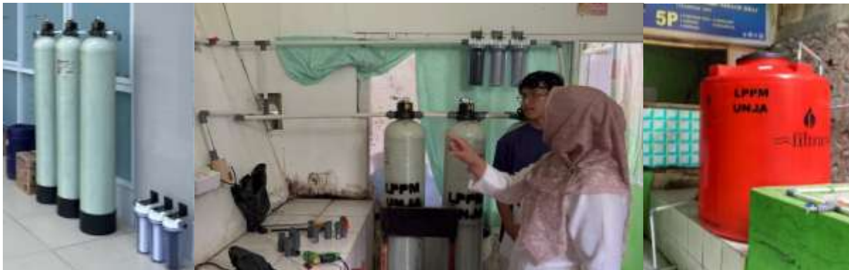
Gambar 2. Pemasangan teknologi Wash station di SD Bustanul Ulum Semen Padang
