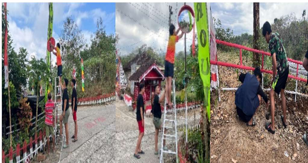
Gambar 2. Pemasangan Cermin Cembung
