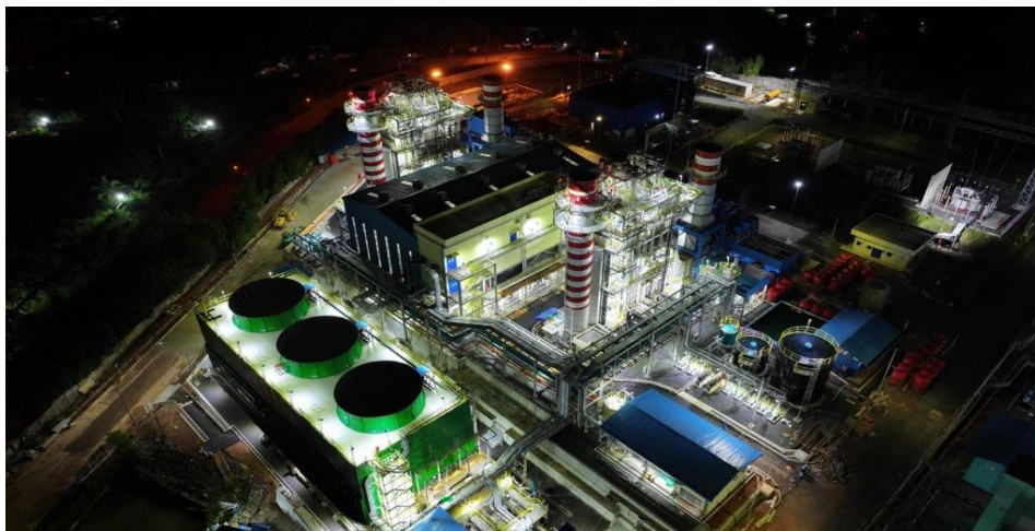
Gambar 1. Pembangkit Listrik Tenaga Gas Uap (PLTGU)
