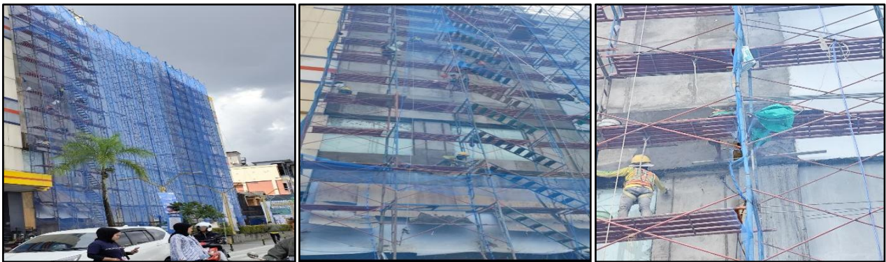
Gambar 2. Proses pekerjaan plesteran
