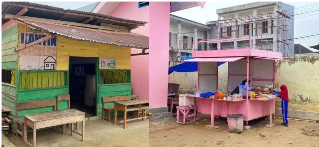
Gambar 3. Kantin SDN 78 Kendari Sumber: Dokumentasi Penelitian, (2025).
